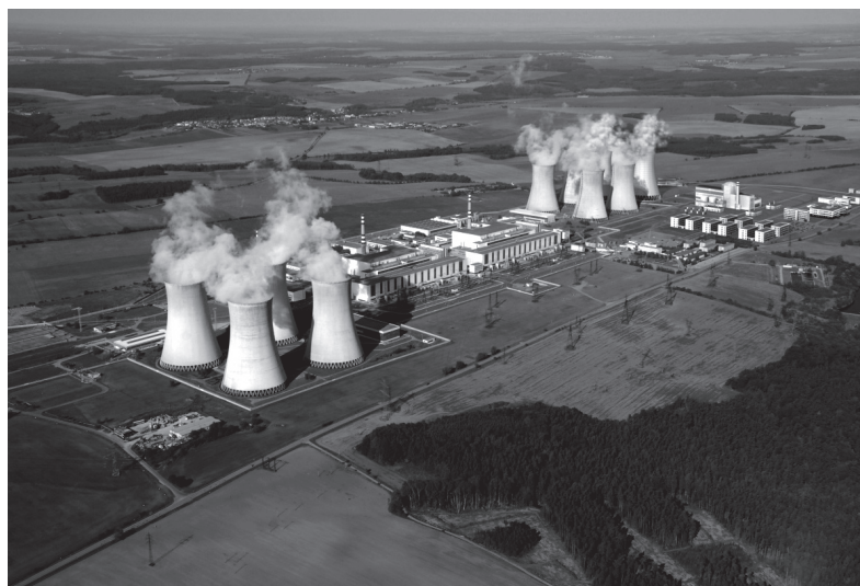
Dukovanų atominė elektrinė.
